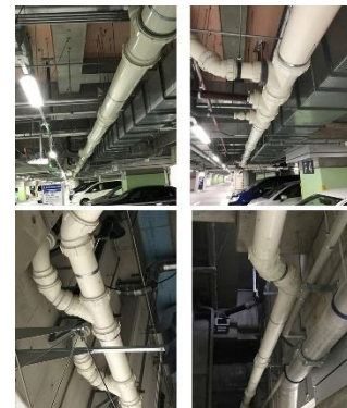
横浜市民病院の地下駐車場の天井配管 (100A～300A)
