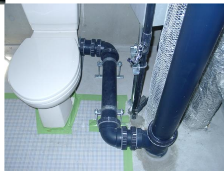
鳴野コーポ 改修工事
