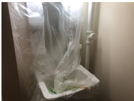
清和台団地住宅 改修工事
